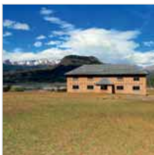
RESTAURACIÓN Y OBRAS ANEXAS Escuela Antigua de Cerro Castillo Página 143
