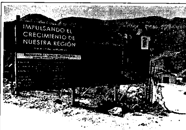
Fotografía N° 3: Vista de letrero de obras dañado.
