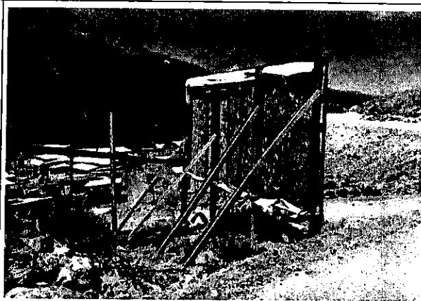
Fotografía N° 2: Vista posterior del letrero indicativo de obra, construido en madera.
