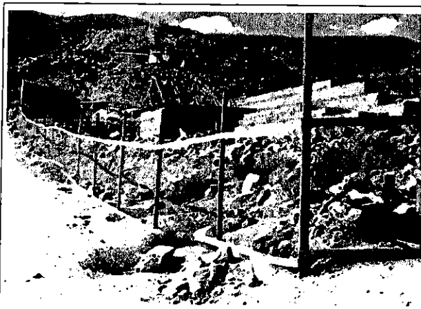
Fotografía N° 1: Vista lateral del cierro provisorio, compuesto por cuarterones y malla metálica.
