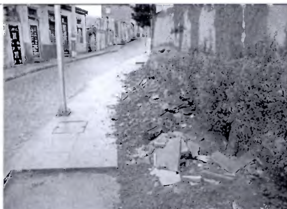
Foto N°22: Acumulación de material de excavación, restos de materiales y escombros calle Carlos Nebel
