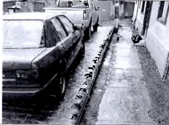
Foto N°25: No se instaló señalética de seguridad en la calle Carlos Nebel
