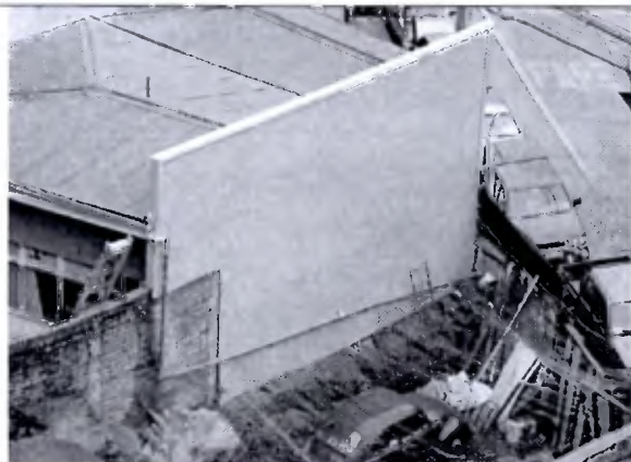
Foto N°7: Bajada de aguas lluvias, canalizada en tuberías de PVC por terreno adyacente, Ascensor Reina Victoria.
