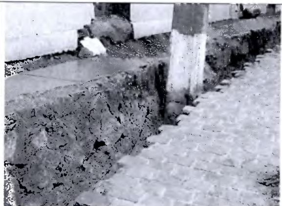
Foto N°26: No se instaló señalética de seguridad en la calle Carlos Nebel
