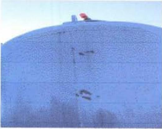
PINTURA DETERIORADA ESTANQUE FILTRO
