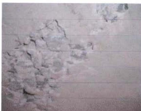
SEGREGACION MATERIAL GRANULAR DEL HORMIGON. ENFIERRADURA EXPUESTA
