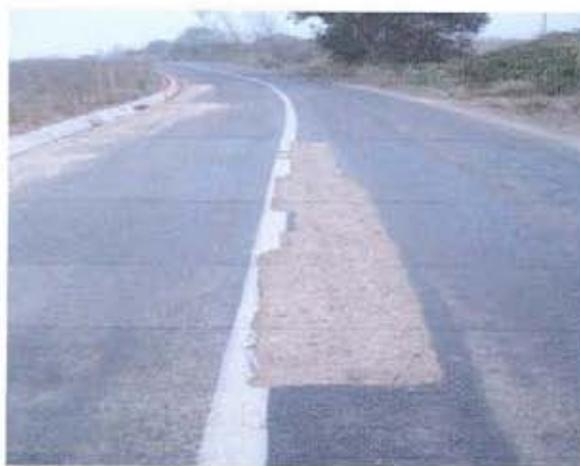
KM 0,800 RETIRO PAVIMENTO DAÑADO Y REPARACION
