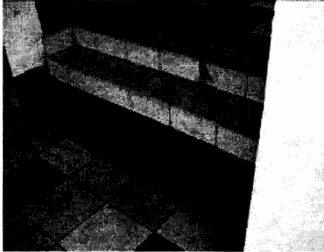
Gradas sin bordes antideslizantes y sin cambio de textura para los no videntes.
