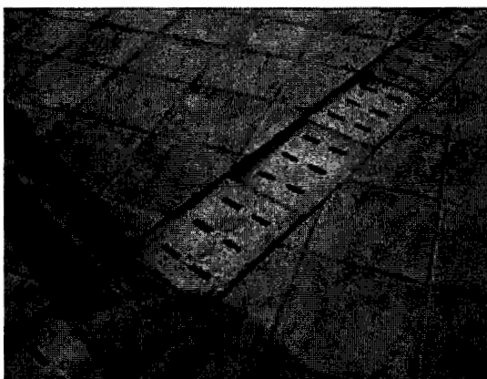
Placas de hormigón, que tapan las canales de aguas lluvias
