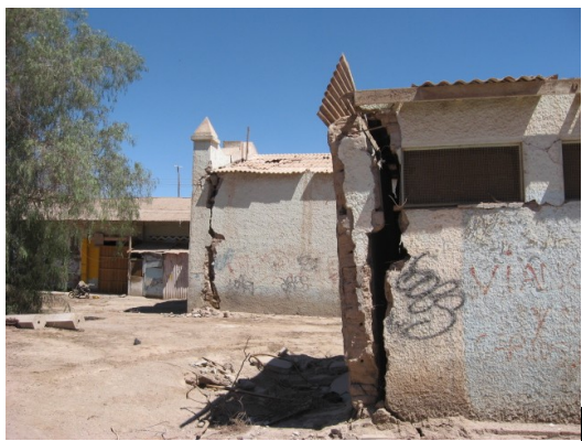
Imágenes N°3, 4 y 5. Daños en la estructura
