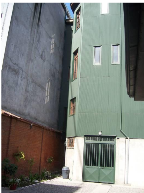
Sector donde se proyecta instalación de elevador
