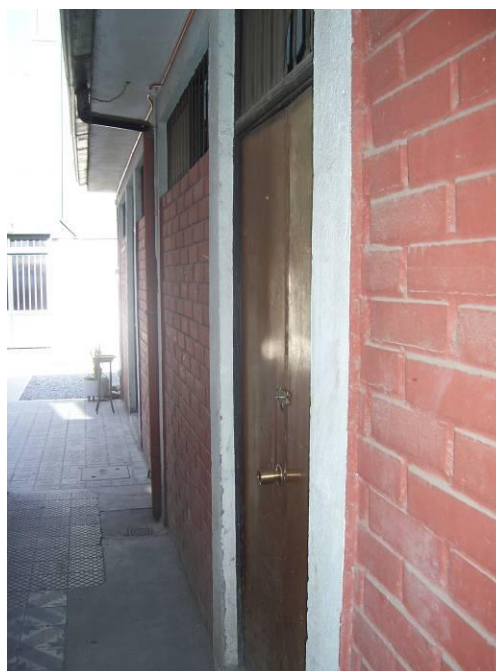
Bodega en patio donde se proyecta sala de guardia
