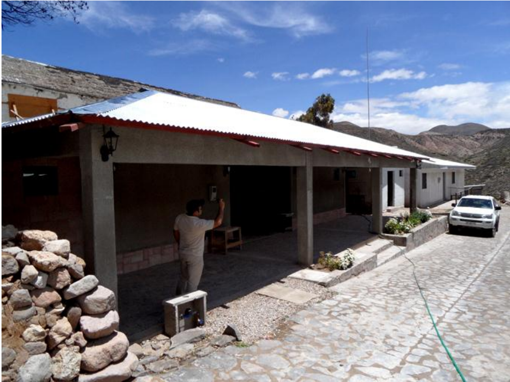
Baño público en la localidad de Socoroma, vía PMU.
