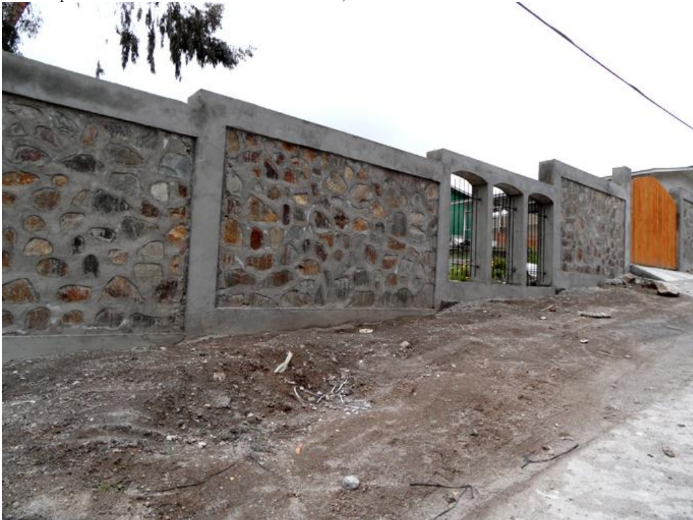
Cierre perimetral del Liceo C-3 comuna de Putre, vía PMU.
